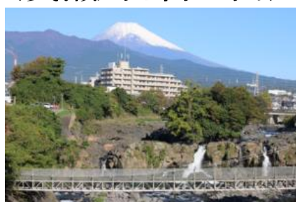
⑦鮎壺の滝吊り橋
