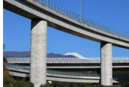
⑪新東名高架橋
