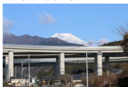
⑩新東名高架橋
